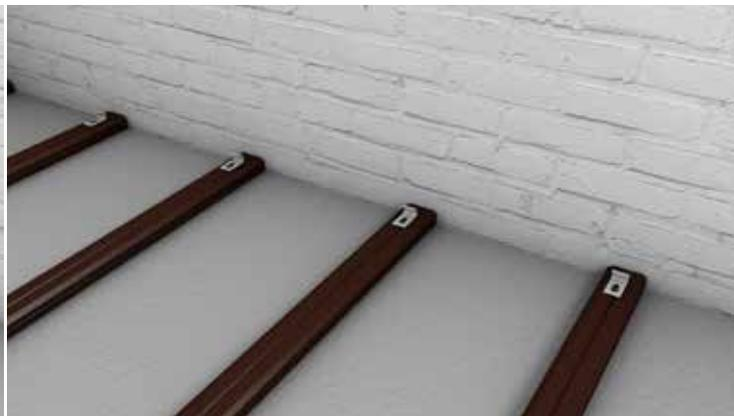
Первая доска задвигается в паз стартовой клипсы до упора. В некоторых случаях, в особенности при монтаже в холодную погоду (**ниже 0°C**), требуется предварительное просверливание несущих лаг перед окончательной фиксацией клипсы. Для более плотной и равномерной фиксации доски используйте киянку. Если основной профиль по
